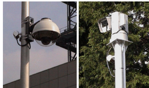
図 2 道路監視システムの屋外設置カメラ 2 基の外観
